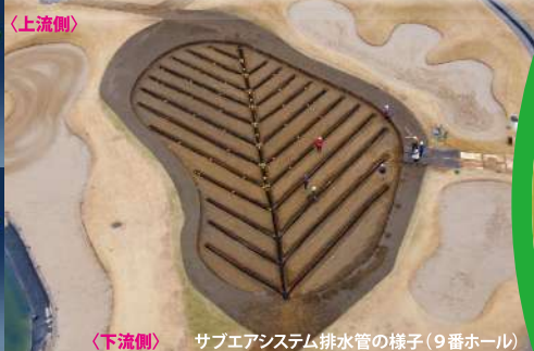
サブエアシステム排水管の様子(9番ホール)
